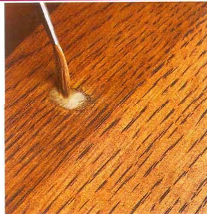
Чтобы пигментный состав не слишком интенсивно окрасил заплатку и древесину вокруг нее, перед подбором цвета нанесите на поверхность заплатки тонкий слой шеллака.
